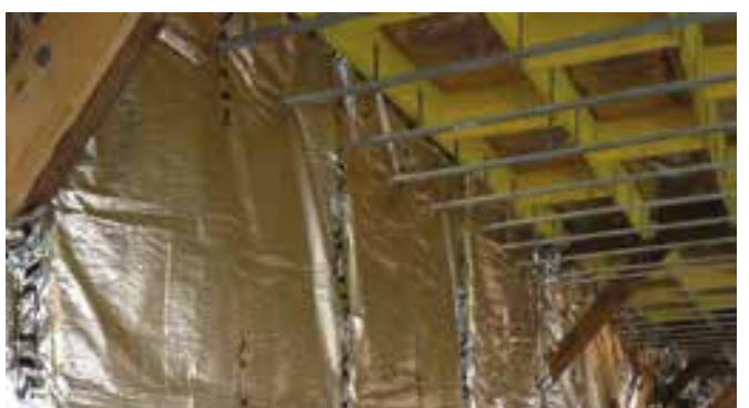
Parois isolées : Murs par l'intérieur en complément de panneaux de SYLVACTIS 40 FX
