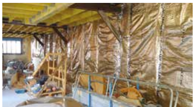
Rénovation d'une habitation à Paris (75)
