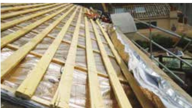
Parois isolées : Toiture par l'extérieur
