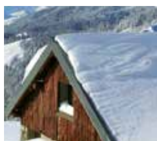
Bâtiment bien isolé
