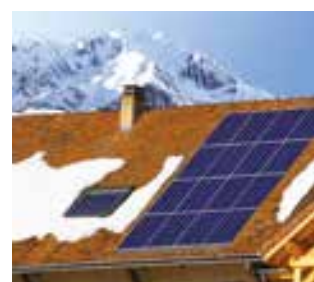
Bâtiment mal isolé
